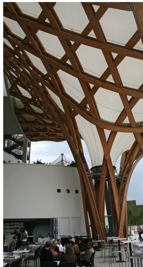
Der Einsatz von Holzleimbändern anstelle von Stahlträgern, wie im Centre Pompidou in Metz/FR, spart diejenigen CO<sub>2</sub>-Emissionen von Treibhausgasen ein, die bei der energieintensive Stahlproduktion anfallen. *Foto: Liptay*
