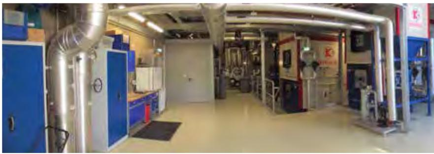
Für die zuverlässige Wärmeversorgung in Bad Mitterndorf sorgen zwei Kohlbach-Kessel mit 5,5 MW.
