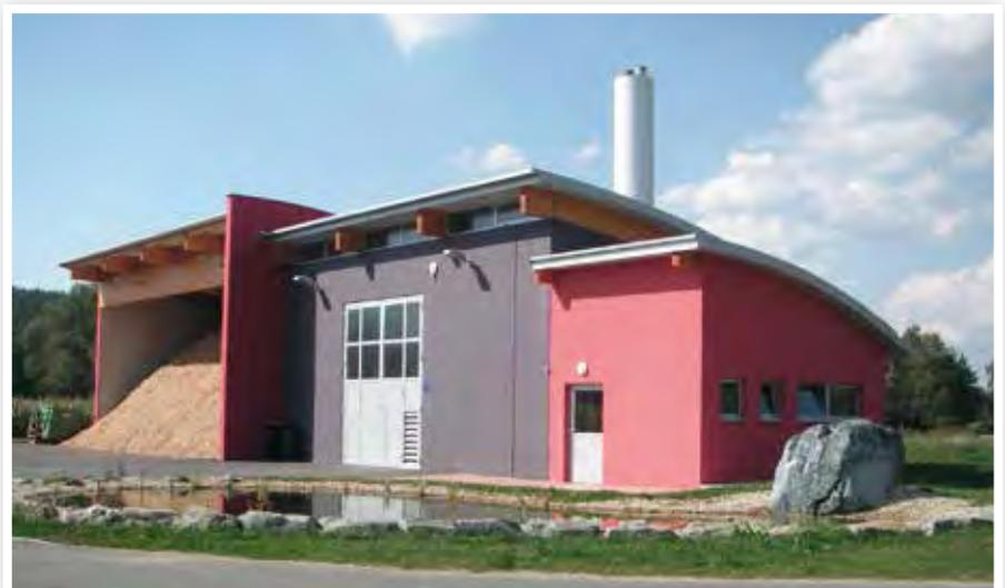
Das 2005 gegründete, von einer Genossenschaft betriebene Heizwerk in St. Martin in der Wart versorgt mit zwei 500-kW-Kesseln etwa 70 Einfamilienhäuser mit Wärme.
