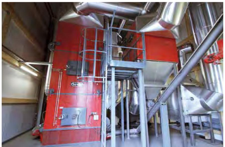
Der 3-MW-Hackgutkessel von Binder wird ohne Pufferspeicher betrieben.
